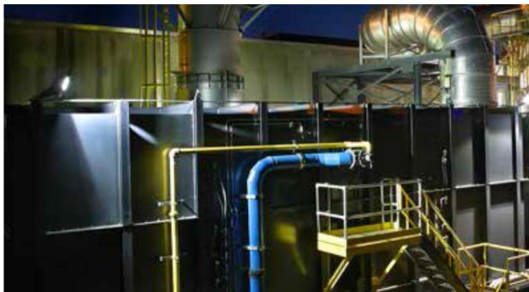
Figure 3-8. B&W Thermal Oxidizer
